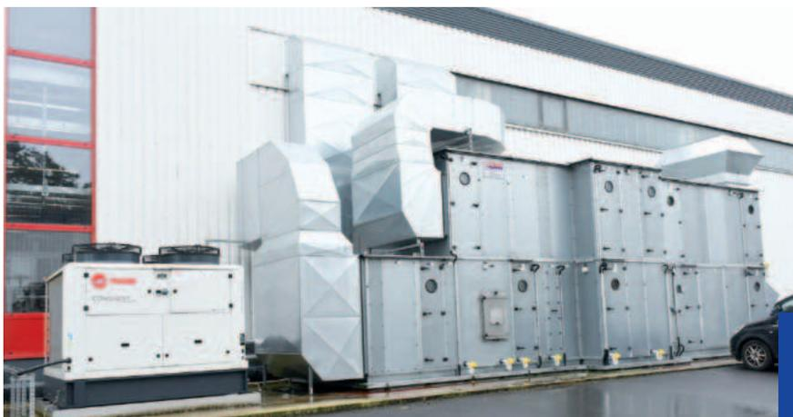
**Kostenlose Maschinenabwärme versorgt die Hallenlüftung mit Heizwärme**
